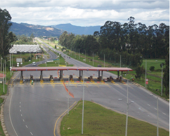
La doble calzada despliega su esplendor a partir del peaje de El Roble, al superar los problemas de Tocancipá y Gachancipá
